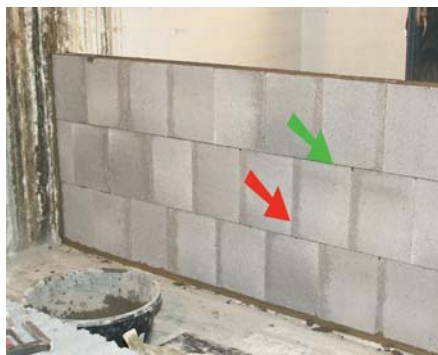
Fig. 1 Nouveau concept sans fermeture des joints verticaux (flèche rouge).
