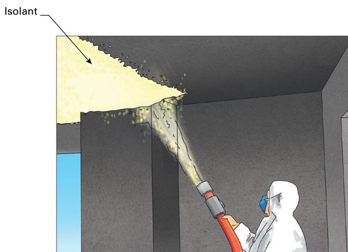
▲ Figure 13 : Projection d'isolant sous plancher
