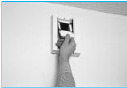
2. Sortir le support des deux volets réglables.
