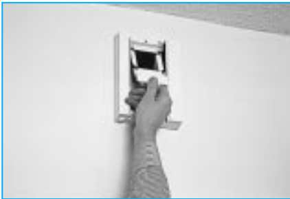
4. Remonter le support des deux volets réglables (vérifier que le débit de pointe n'est pas enclenché lors de cette opération).
