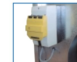
Variante : un disjoncteur tri-cadenassable peut remplacer l'interrupteur de proximité
