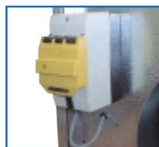
Variante : un disjoncteur tri-cadenassable peut remplacer l'interrupteur de proximité
