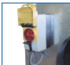
*Un disjoncteur tri-cadenassable peut être monté en option sur les caissons.*
