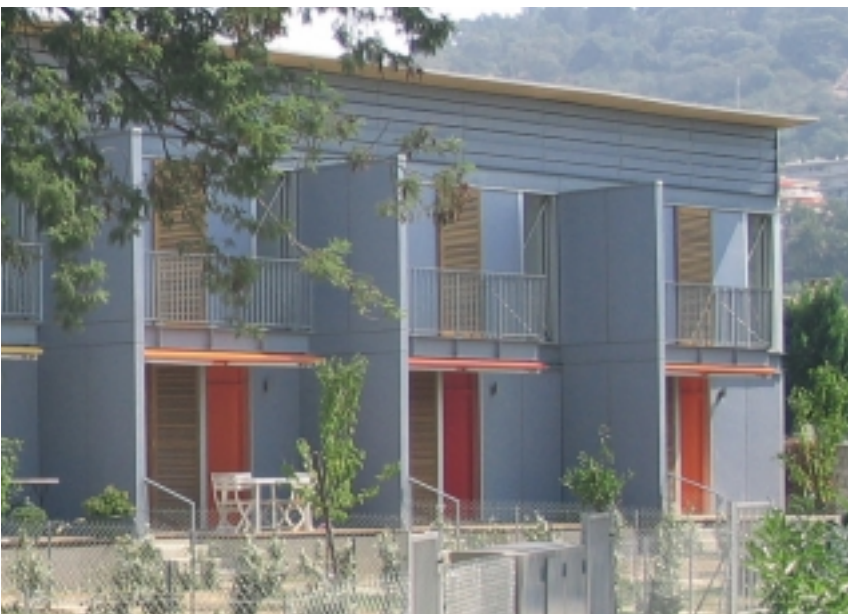
Architecte : Hannouz & Janneau
