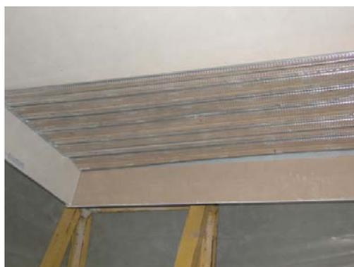
La laine est ensuite projetée en épaisseur de 120 sur le treillis métallique et la finition est réalisée au rouleau.
