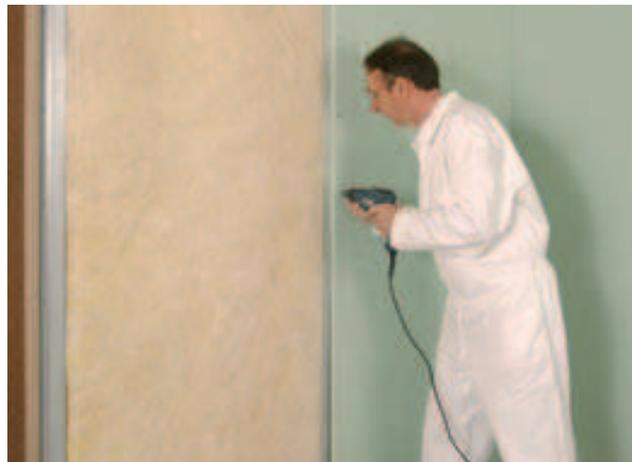
Son ossature à entraxe 900 mm apporte une économie de matière par rapport aux solutions traditionnelles à entraxe 600 ou 400 mm, et une économie de main d'œuvre en supprimant le vissage sur le montant intermédiaire. De même, la pose d'une seule plaque Placoplatre® BA25 dB par parement facilite la mise en œuvre et diminue les temps de pose.
