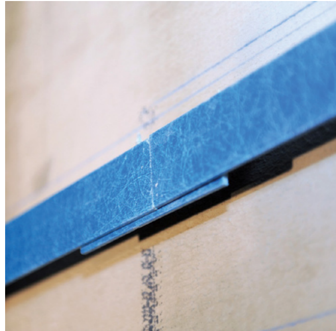
Lisses raccordées par l'intermédiaire d'une pièce d'appui.
