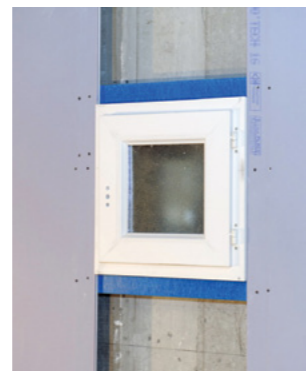
Lisses d'imposte et d'allège disposées horizontalement de part et d'autre des menuiseries ; lisses vissées sur l'arrière des plaques.
