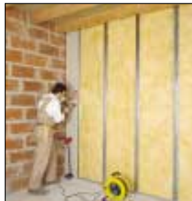
Vissage du deuxième parement à joints décalés par rapport au premier parement.
