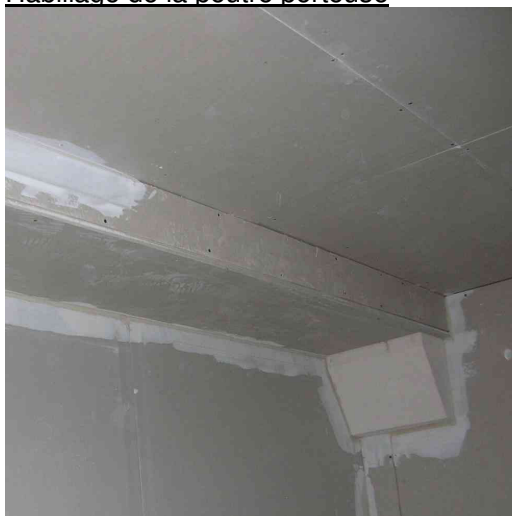
Habillage de la poutre porteuse
