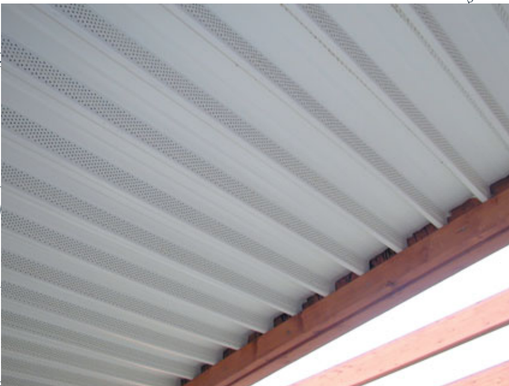
Exemple d'aspect de profils-nervurés HACIERCO perforés en âme – Système HAIRAQUATIC
