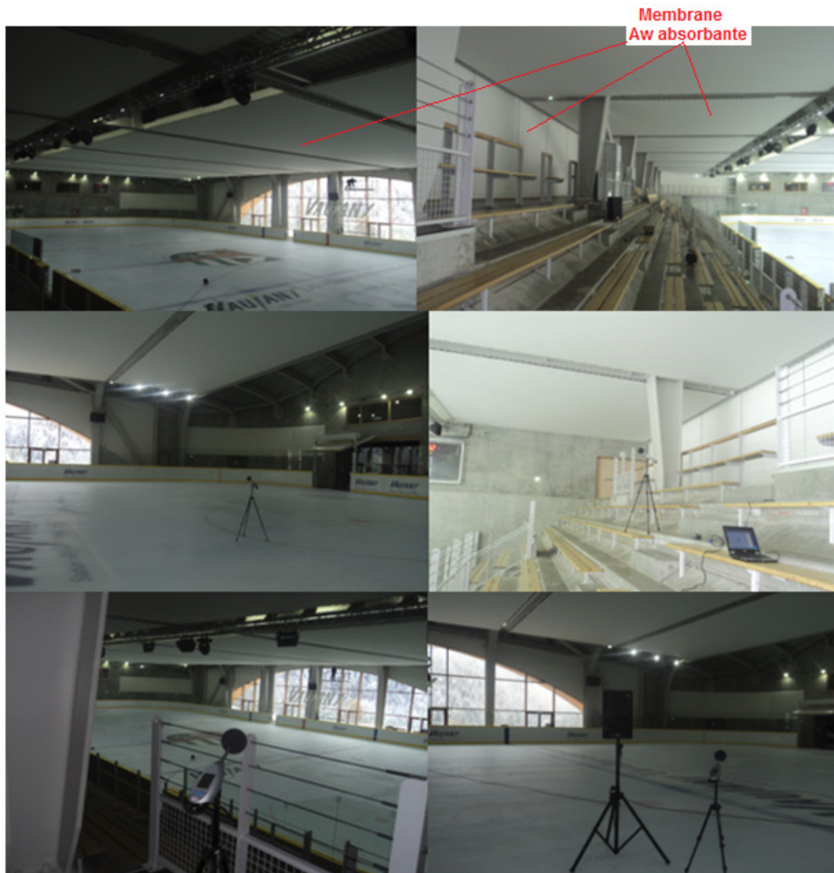
Figure 1. Photo montrant plusieurs vues différentes de l'intérieur de la patinoire de Vaujany après la traitement du plafond et des murs avec la membrane BATYLINE Aw.
