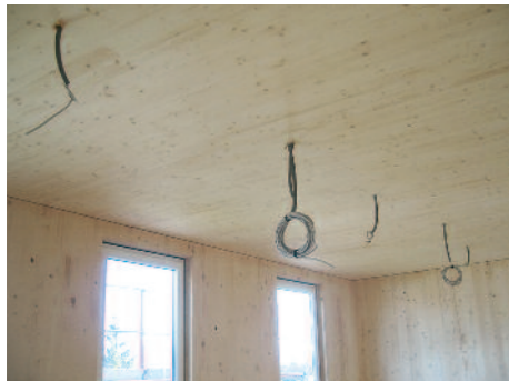
Plafonnier en CLT visible
