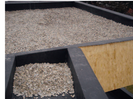
Gravillons sur étanchéité
