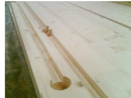
Gain de temps sur chantier avec découpes en usine pour le passage des réseaux
