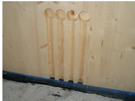
Blocs prises fraisés en usine
