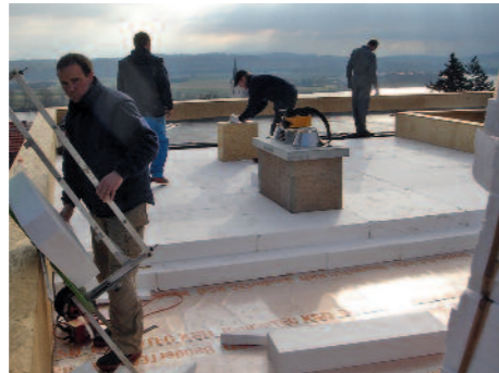
Étanchéité sur toiture CLT
