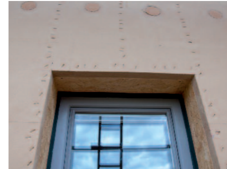
Isolation en fibre de bois par l'extérieur
