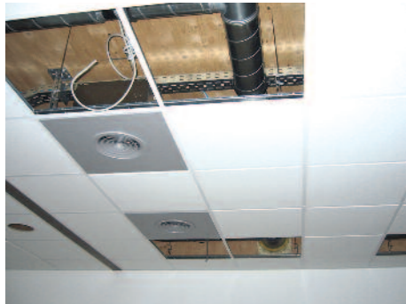
Faux plafonds et passages des gaines
