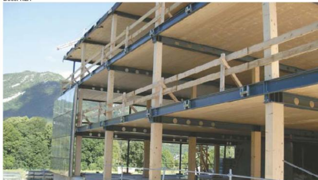
Les panneaux sont découpés en usine pour intégrer les réservations des menuiseries extérieures, les passages de gaines, etc. Ils sont repérés et livrés prêts à être montés sur chantier.
