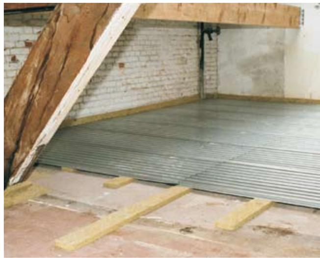
Mise en place des bandes résilientes (laine minérale ou produit équivalent) pour un plancher béton sur profils LEWIS® flottant et insonorisé
