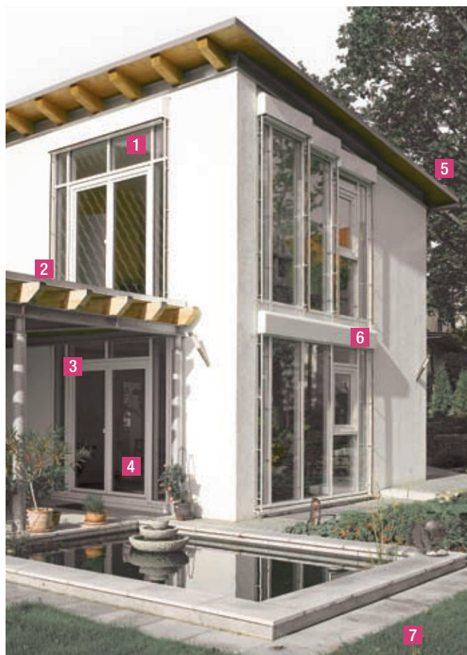
Exemples de postes sur lesquels peuvent porter les améliorations énergétiques.
