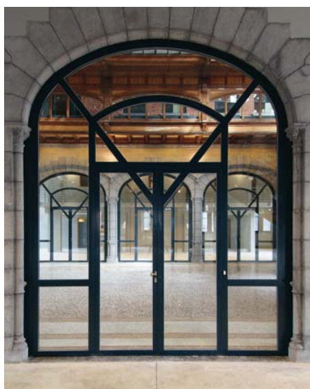
Les intercalaires foisonnent à environ 120° C et se transforment en un écran rigide et opaque.
