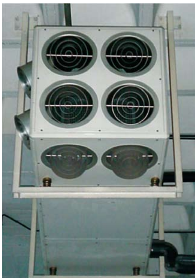
Système de ventilation isolé avec VIBRABSORBER®
