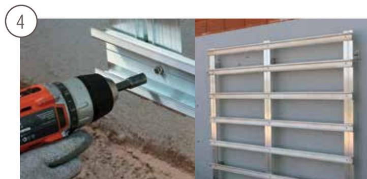
*Fixation des rails horizontaux sur l'ossature verticale*
