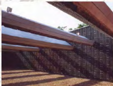
Centre de Tir de l'Ecole de Police CHATEL GUYON (63)
