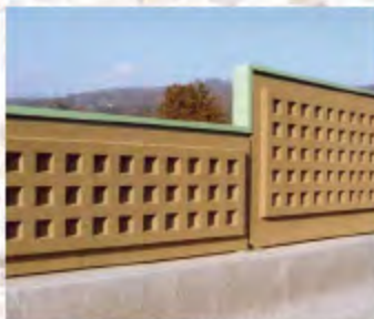
Chantier de Gan (64)
