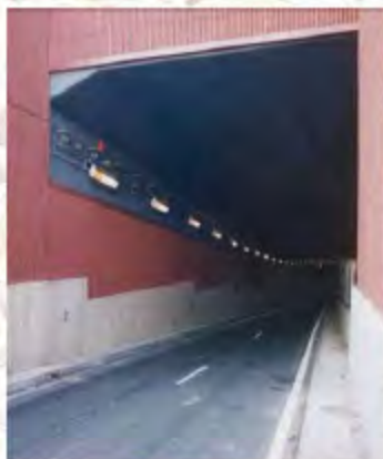
Tunnel REPIQUET A86
