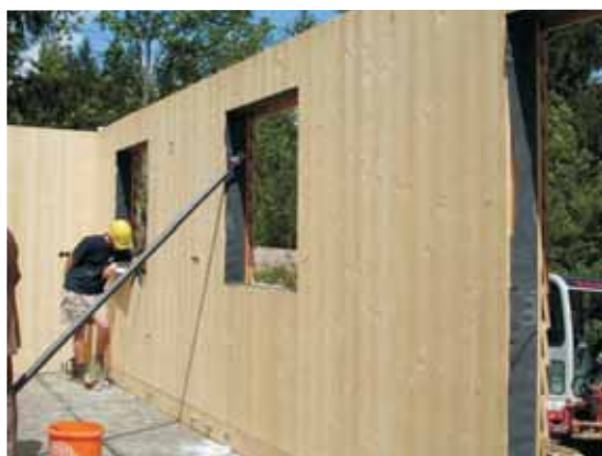
BBS murs préfabriqués avec isolation, façade et installation électrique
