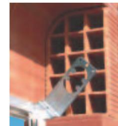
Console emboîtée dans la glissière avec sa coquille pour enroulement intérieur.
