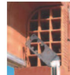
Console emboîtée dans la glissière avec sa coquille pour enroulement extérieur.
