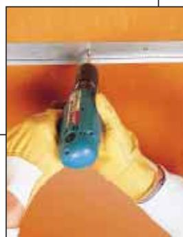
Vis auto-foreuse pour fixation (exemple de rives de faux-plafond)
