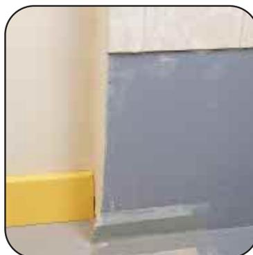
Système de protection d'un pied de cloison : renfort d'angle + étanchéité.
