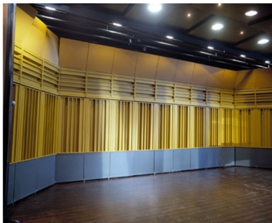
Panneaux Multiwing (sonogamme) permettant de faire varier l'acoustique de la scène
