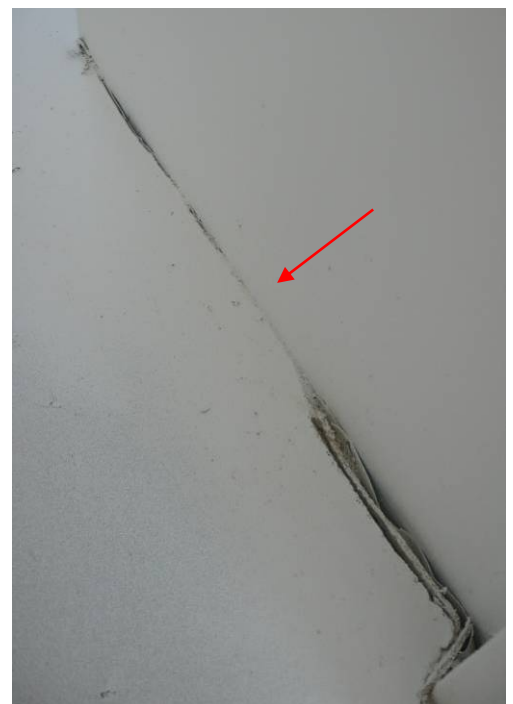
Bande périphérique glissée sous la chape
