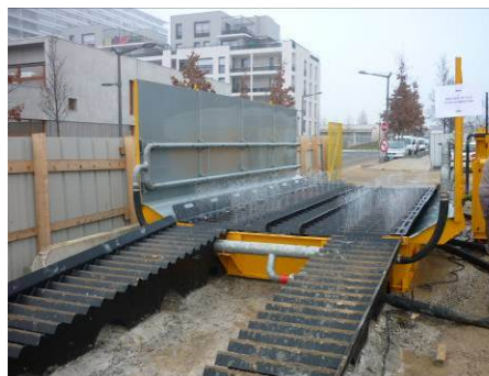
Exemple de système automatisé de nettoyage des roues des camions
