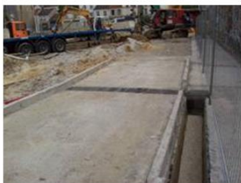
Aire de lavage des camions (source : Inddigo)
