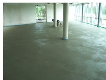
Préparations pour le revêtement de sol
