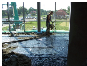
Montage de la chape
