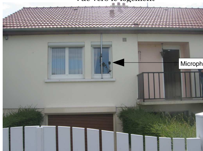
Vue vers le logement
