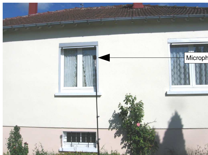
Vue vers le logement
