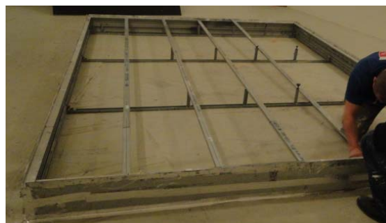
↑ Mise en place des fourrures ↑
