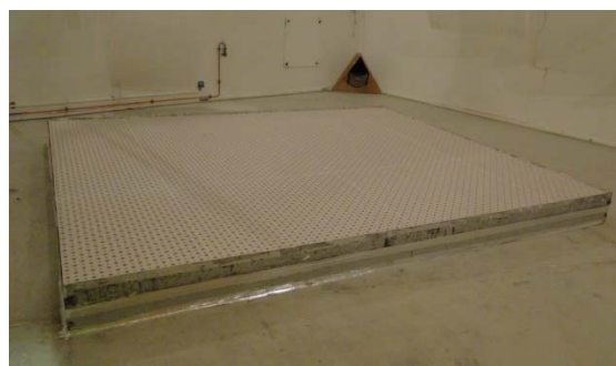
↓ Vue du plafond ↓
