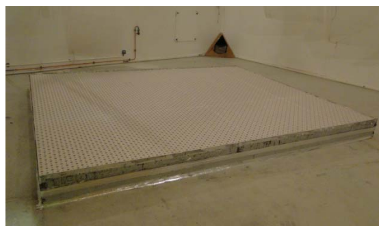
↓ Vue du plafond ↓
