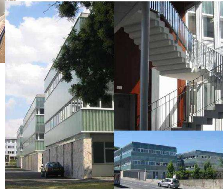
Ateliers du lycée Godard Roger Épernay (51) Thiénot - Ballan Architectes
