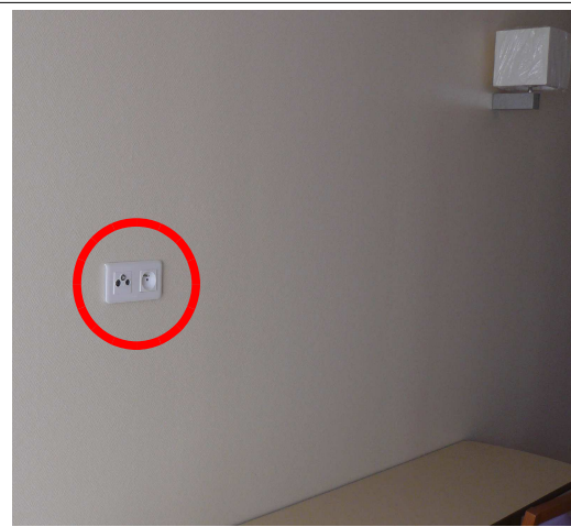
Encastrement de boîtiers électriques
