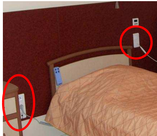
Encastrement de boîtiers électriques
