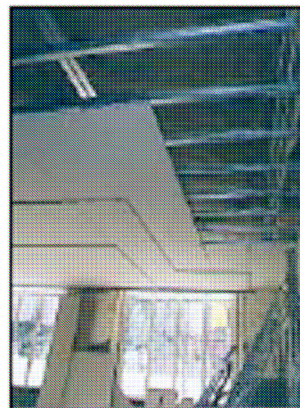
Plafond Mégastil® de grande portée avec suspentes Antivibracelle Placostil®.
