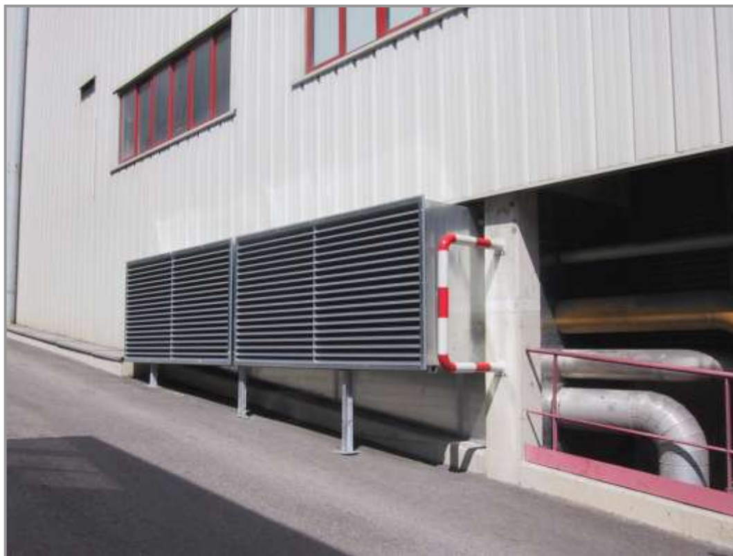
Entrée d'air sur local compresseur
