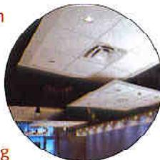
6 - **Ekla Latéris** - plafond acoustique (**ROCKFON**) Panneau acoustique en laine de roche volcanique dont la face apparente est revêtue d'un voile minéral peint en blanc uni. La face côté plénum est revêtue d'un complexe d'aluminium. Les bords de type E815 (feuillure avec un angle droit) sont peints en blanc. Absorption acoustique (aW =0.80) et Isolation acoustique au dos. Ekla Latéris est un plafond adapté pour les bureaux. [www.rockfon.fr](http://www.rockfon.fr)
