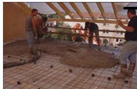
**Le béton est coulé sur le plancher après la fixation des connecteurs métalliques.**
