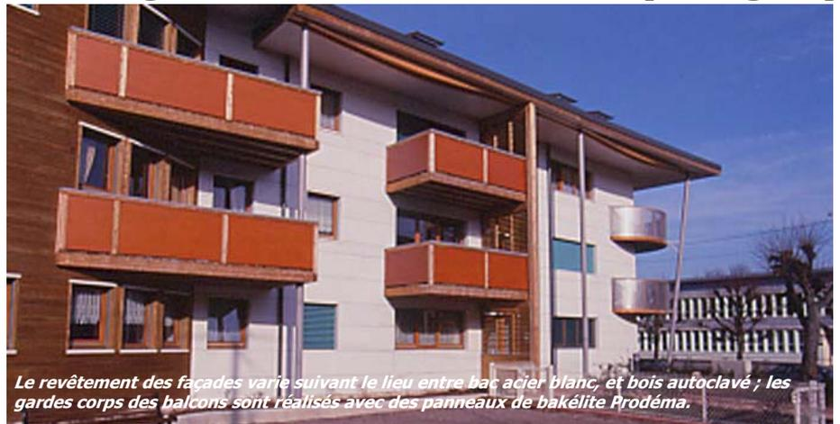
Le revêtement des façades varie suivant le lieu entre bac acier blanc, et bois autoclavé ; les garde corps des balcons sont réalisés avec des panneaux de bakélite Prodéma.
