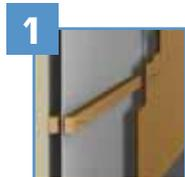
Respecter une lame d'air de 20 mm au minimum de part et d'autre de l'isolant :
