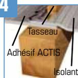
Recouvrir les jonctions avec l'adhésif ACTIS et idéalement, fixer un tasseau\* pour parfaire l'étanchéité.
