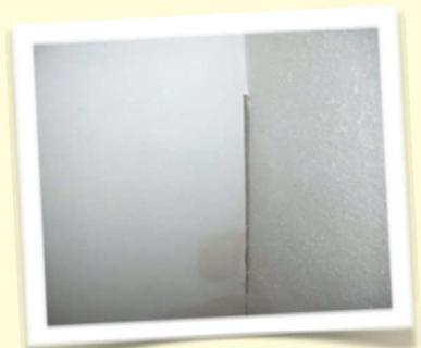
Simple et rapide à mettre en oeuvre, un joint acrylique permettra de traiter l'angle rentrant créé par ces deux surfaces en Mono Acoustic.
