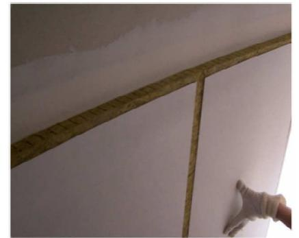
**Le plafond Mono Acoustic Flecto permet de réaliser des surfaces concaves ou convexes avec un rayon de cintrage de 50 cm minimum !**
