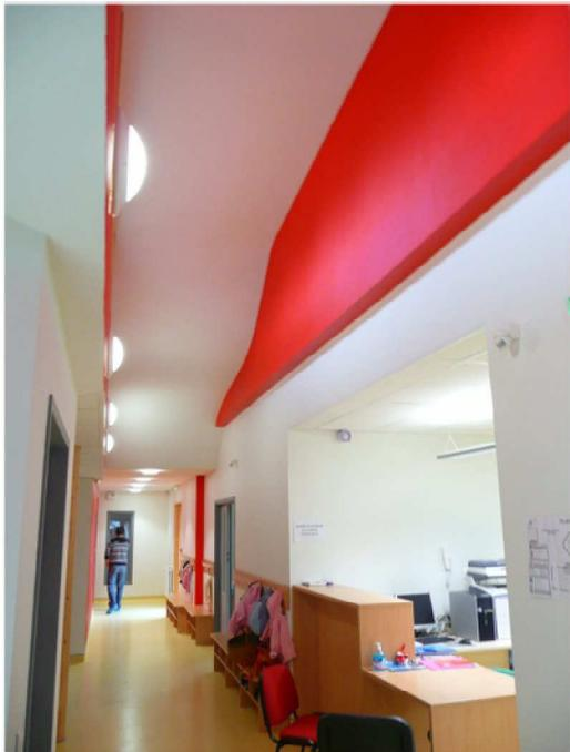
**La mise en oeuvre d'un Mono Acoustic Flecto** passe d'abord par la réalisation d'une première «coque» reprenant la géométrie souhaitée.
