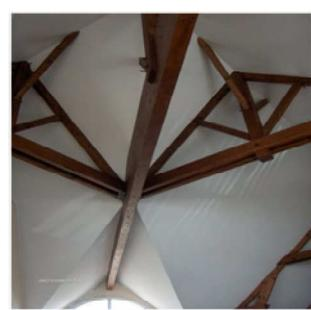
Une plage en plaque de plâtre renforcée par une bande armée permettra d'assurer une arrête vive résistante et parfaitement rectiligne.
