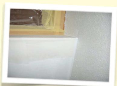
Après projection de l'enduit de finition, l'ensemble est esthétiquement homogène et ne laisse apparaître aucune nuance.
