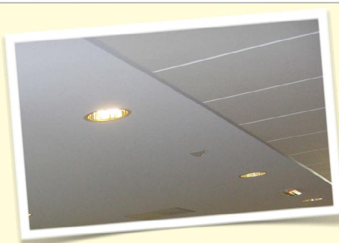
Le T15 ou T24 assure la reprise de charge et la finition entre un plafond modulaire et un plafond Mono Acoustic
