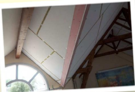
Après projection de l'enduit de finition, l'ensemble est esthétiquement homogène et ne laisse apparaître aucune nuance.
