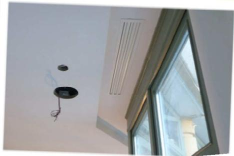
La retombée en plaque de plâtre peut recevoir le même enduit de finition que le Mono Acoustic ou peut être peinte.
