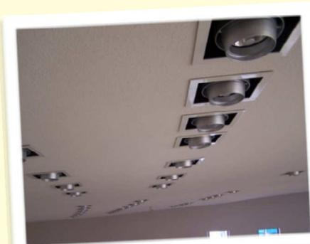
Si le poids du luminaire ou du haut-parleur dépasse 1,0 kg, il est nécessaire de prévoir un renfort d'intégration.
