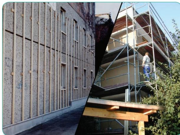
Emploi de la ouate de cellulose DÄMMSTATTs CI 040 pour l'isolation extérieure d'une facade « en dur » lors d'une opération de réhabilitation
