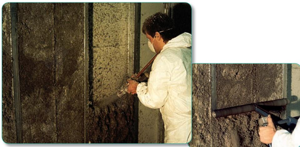
Projection des flocons de cellulose par flocage et suppression de l'excédent à la fraise (petite image)
