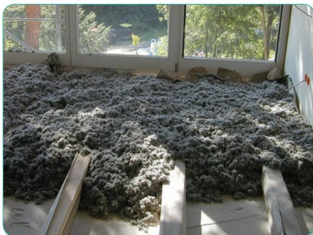
Soufflage sur une surface, dans le comble
