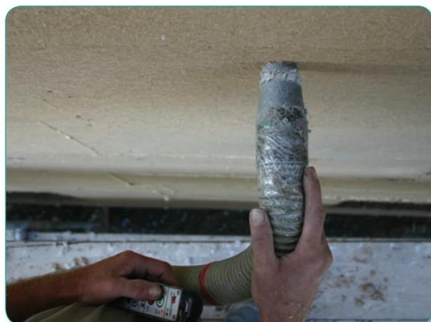
Tuyère pour l'insufflation d'une isolation de faible épaisseur
