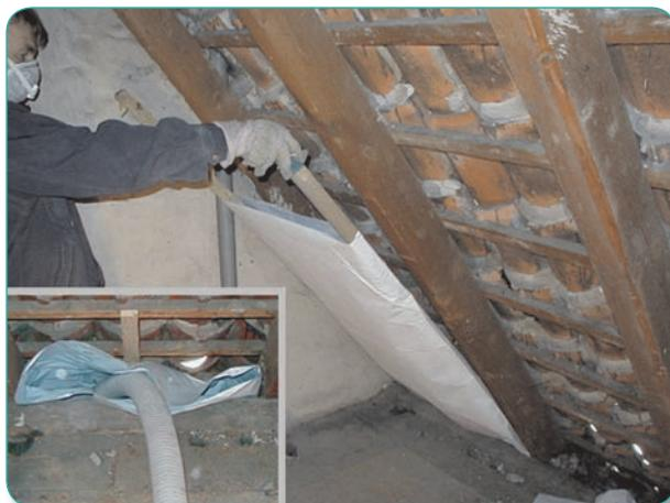
Montage du sac isolant et insufflation de la ouate de cellulose (petite image)
