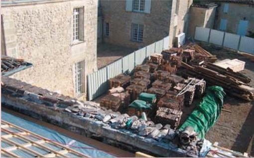
Les tuiles sont déposées puis remises en œuvre après traitement de l'isolation du toit
