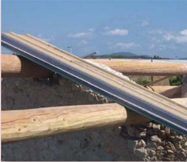
Pose de Fibratec ULTRA Plâtre sur les pannes de la charpente
