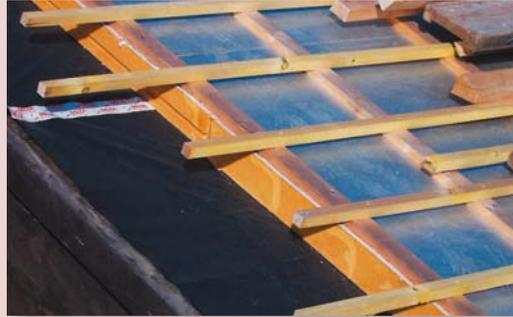
Knauf Thane Sarking évite les ponts thermiques
