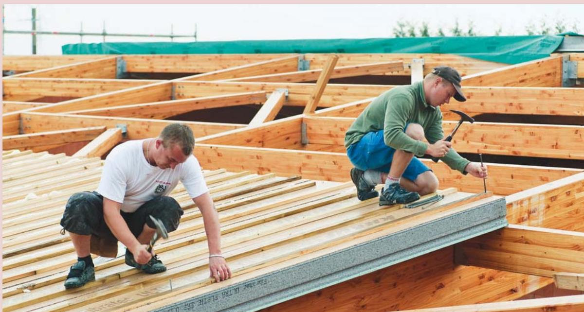
Fixation (clouage des panneaux Fibratex à la charpente)
