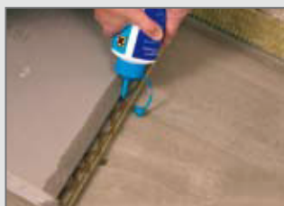
Fig. 5- Dépose d'un boudin zigzag
