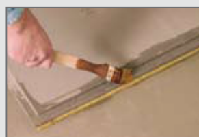
Fig. 4 - Nettoyage des feuillures des plaques
