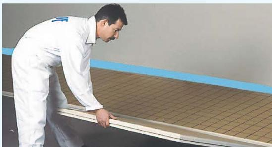
Pose de l'isolant à joints croisés
