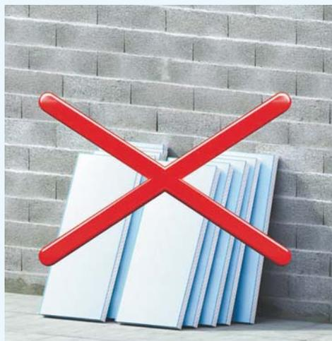
Fig. 28 : Stockage des panneaux à plat
