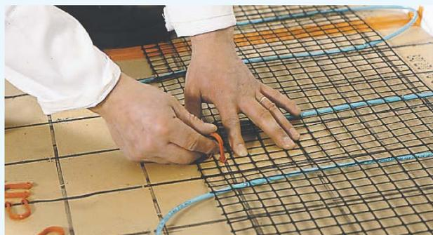
Pose de la trame chauffante dans le cas de panneaux à bords recoupés (avec joints pontés au ruban adhésif)
