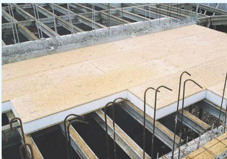
Pose de panneaux agrafés sur coffrage industrialisé
