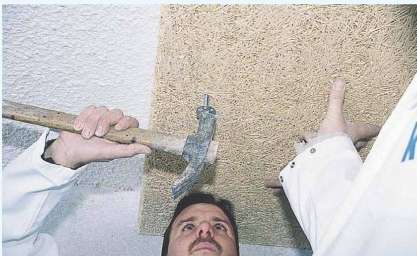
Fixation mécanique avec FIB M
