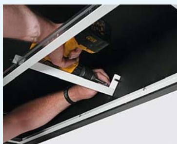
Le maintien et l'écartement de l'ossature secondaire est assuré par un distanceur (un distanceur tous les 2 400 mm maximum)
