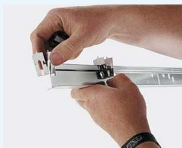
Important : avant de fixer l'ossature secondaire il faut penser à placer les clips DG permettant la liaison / la fixation avec l'ossature primaire
