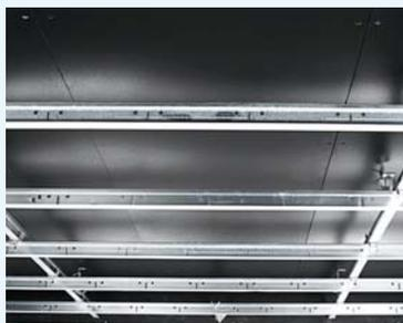
L'ossature secondaire T de 24 est mise en œuvre perpendiculairement à l'ossature primaire en respectant le calepinage
