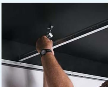
L'ossature primaire en T de 24 est montée perpendiculairement au sens des dalles. L'écartement entre porteurs est de 1 200 mm et l'ossature primaire est relevée de 48 mm par rapport à la cornière
