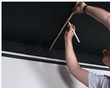
La fixation de l'ossature primaire doit se trouver à 200 mm maximum du mur
