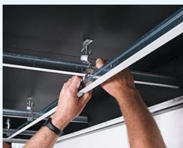
La fixation est assurée par pression sur le clip DG du bas vers le haut
