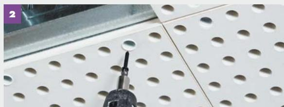
Avec le nouveau plafond Delta Linear, la plaque dispose d'un bord décroché qui reste nu. Elle est ensuite fixée par une vis qui s'insère dans un capuchon, lui-même installé dans la perforation et qui épouse parfaitement sa forme. Il est donc inutile de procéder à la reprise d'enduisage de la tête de vis car elle est invisible.
