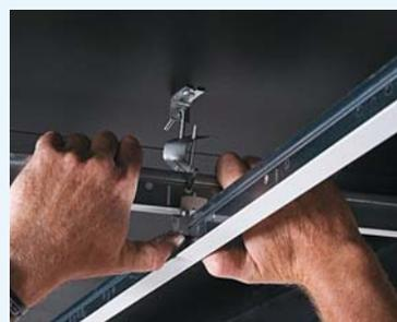
L'ossature secondaire est fixée à l'ossature primaire grâce au clip DG
