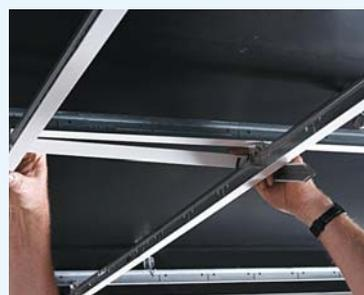
Mise en place des distanceurs qui sont posés parallèlement et à moins de 10 cm de l'ossature primaire
