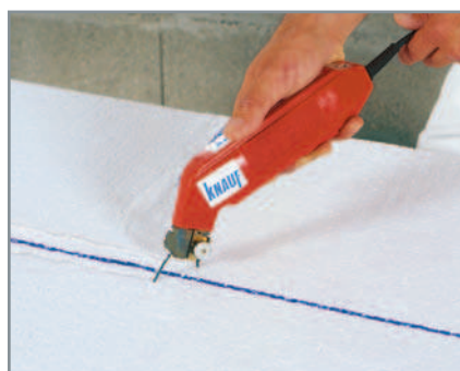
Fig. 17 : Découpe de l'isolant
