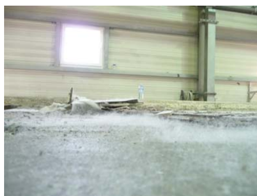
6 - Dalle support après démontage de la maquette
