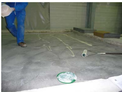
1 - Pose de la colle Sipryl au rouleau
