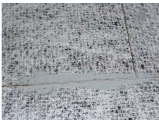
3 - Utilisation du mastic entre plaques
