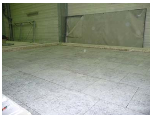
2 - Pose droite des plaques
