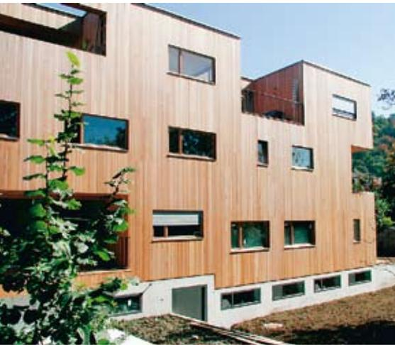
Les caissons multiples LIGNATUR ont été mis en œuvre en tant qu'éléments de couverture exécutés en REI 60 en raison de la forte imbrication des appartements. La protection phonique plus élevée exigée pour les planchers de séparation d'appartements a été obtenue grâce à un sous-plancher suspendu et une chape liquide anhydrite.
