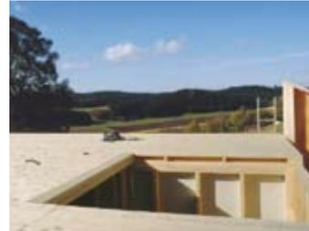
Montage du toit en pente constitué de coques LIGNATUR. Grâce à la grande capacité porteuse, il est possible de renoncer aux pannes intermédiaires.
