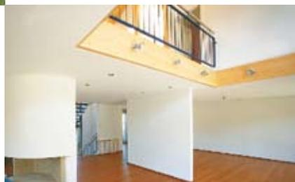
Cette solution n'a posé aucun problème puisque les éléments de couverture LIGNATUR peuvent être tendus sur d'importantes portées, d'une paroi de pignon à l'autre. Il a même été possible d'intégrer de petits spots au plancher.
