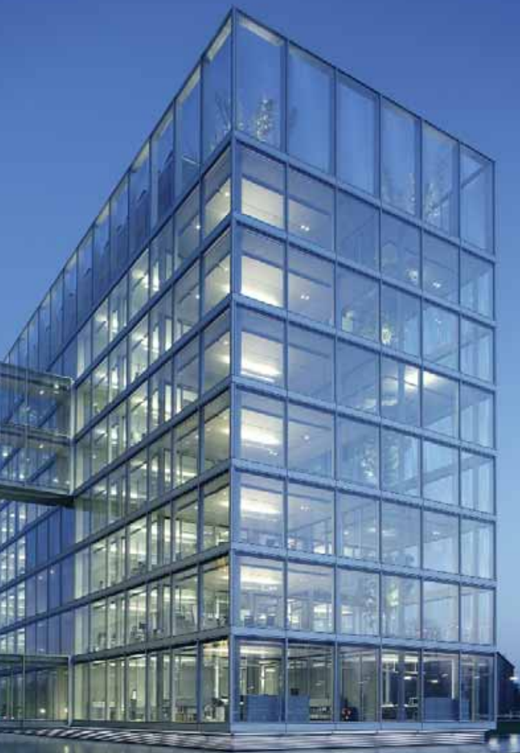
Gelsenwasser AG, Gersheim, Allemagne Architectes : Anin-Jeromin-Filiditis & Partner
