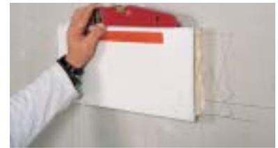
Positionner le caisson dans le manchon, vérifier le niveau.
