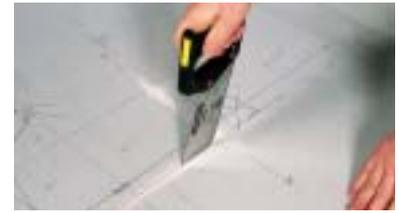
Découper la plaque et le doublage à la scie. Mettre en place la plaque.
