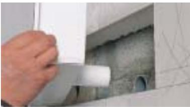
Positionner à sec le caisson qui se trouve guidé par la sortie mâle couissant dans le manchon de traversée de mur. Seul le niveau est à vérifier. Oter le caisson.
