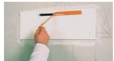
Oter la protection de mortaise et fixer le régulateur.
