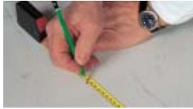
Reporter la position de l'axe du manchon sur la plaque de plâtre, y positionner le gabarit joint dans l'emballage et tracer la découpe.
