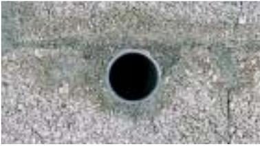
Après coupe à l'épaisseur du mur, mettre en place le manchon en traversée de maçonnerie. Quand les enduits extérieurs sont terminés, y clipser la grille à ailettes anti-pluie.
