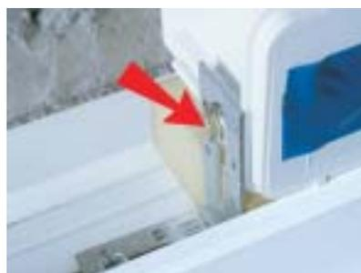
Elle se fait par les extrémités de l'entrée d'air à l'aide d'équerres et de visseries du commerce sur la queue d'aronde du dormant. L'ensemble est ainsi réglable dans les trois dimensions.
