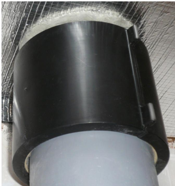
Bride acoustique BRMLT en partie haute de conduite juste sous le toit du laboratoire.
