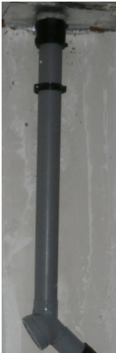
Longueur de tube droite qui est collée au raccord acoustique à 45° CT44A et fixée avec un collier Phonoklip. Bride acoustique BRMLT en partie haute de tube.
