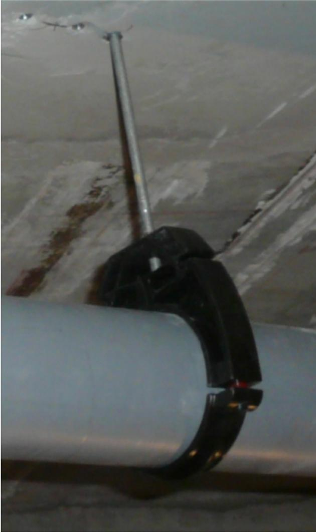
Fixation du tuyau avec un collier Phonoklip. Tige filetée d'une vingtaine de centimètres en diamètre 8 mm. On garde les entretoises rouges pour le serrage.
