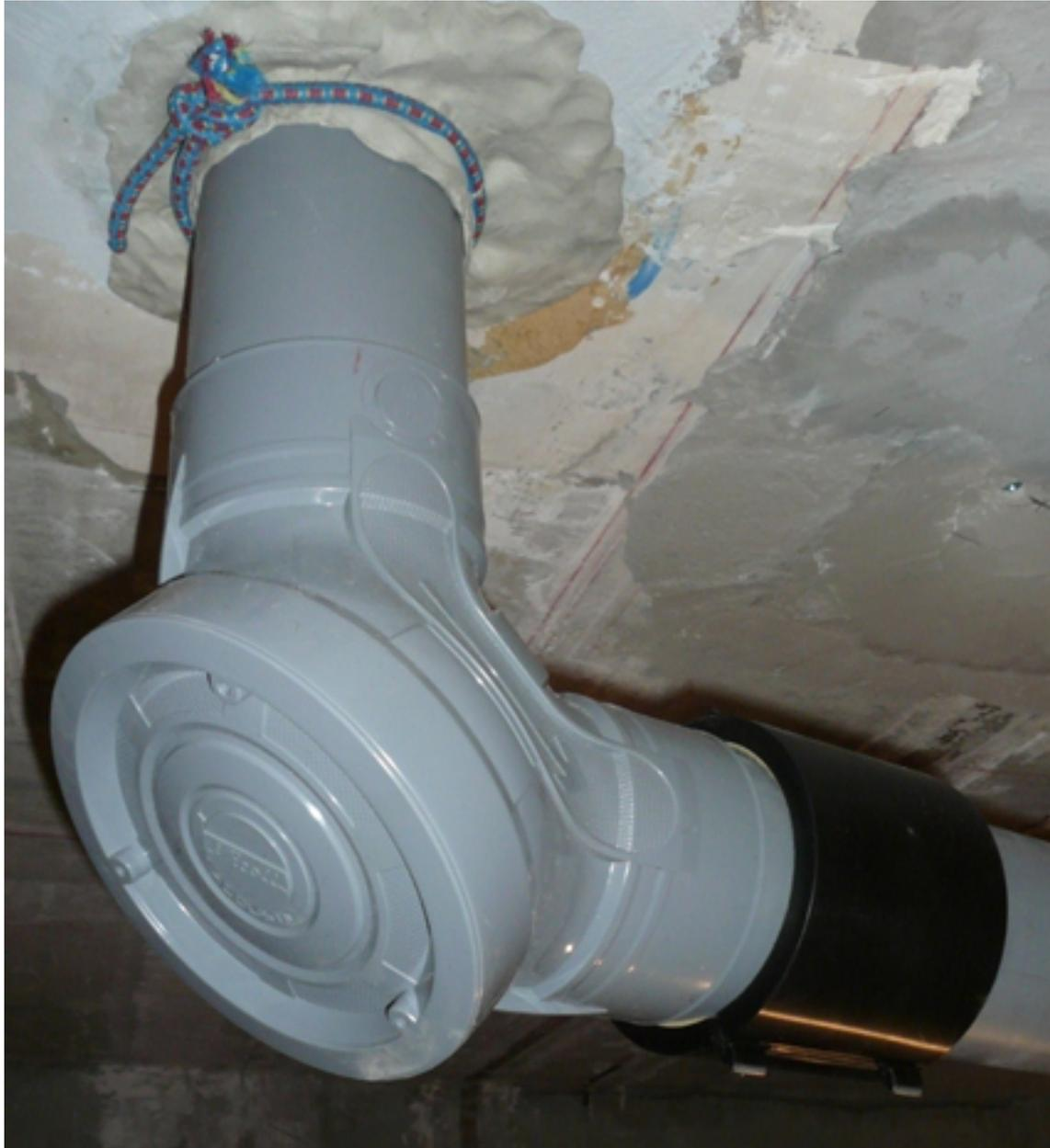
Pied de chute, raccord acoustique (CT88A) et bride acoustique (BRMLT).
