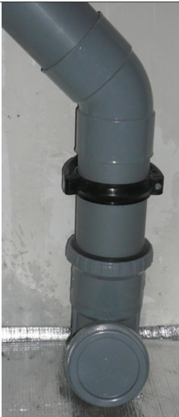
Raccord acoustique à 45° CT44A manchonné à la longueur de tube oblique. Bride acoustique BRMLT.
