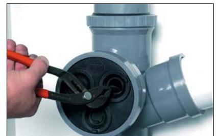
**8 -** En fonction du diamètre des tubes à raccorder, **retirer** à l'aide d'une pince les languettes d'amorçage des opercules correspondants.
