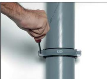
**6 - Serrage** du collier isophonique  $\varnothing$  100 mm sur le tube hélicoïdal acoustique.
