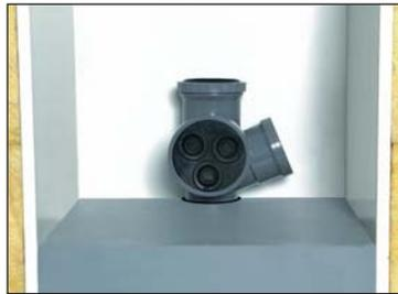
**2 - Mise en œuvre** de la culotte Chutunic-A sur le tube hélicoïdal acoustique du niveau inférieur au travers de la réservation du plancher.
