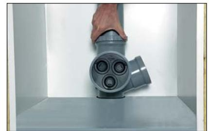
**5 - Emboîtement** du tube hélicoïdal acoustique dans la culotte Chutunic-A et **serrage** de l'ensemble bague/joint.
