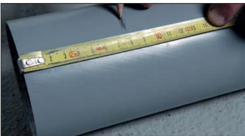
**4 -** Après le **Repérage** de la dilatation sur le tube hélicoïdal acoustique, faire **coulisser** l'ensemble bague/joint de la culotte Chutunic-A sur le tube jusqu'au repère.
